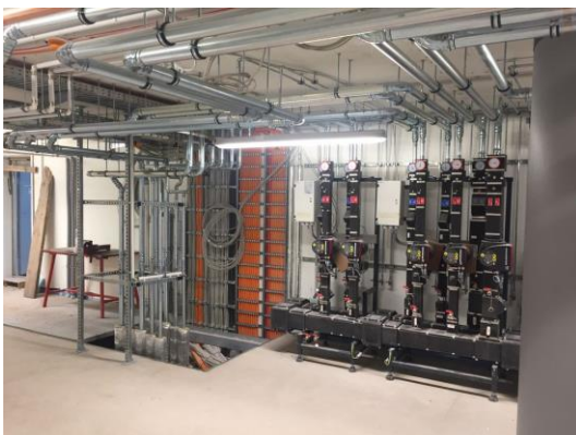
Blick in den Haustechnik- und Anschlussraum
