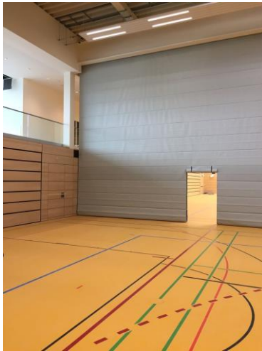
Rauntrennwände in der Dreifeldhalle
