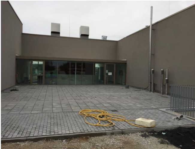
Eingang vom Schulhof
